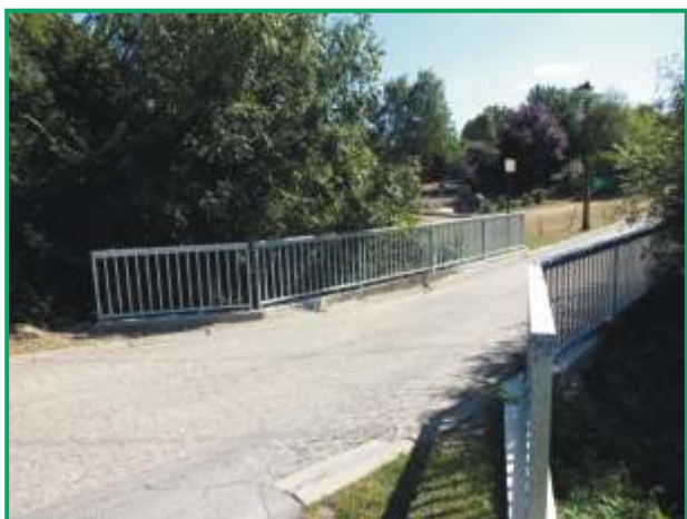
Pose de barrières sur le pont enjambant le « Rau de la Ravette » près du parking du nouveau cimetière.
