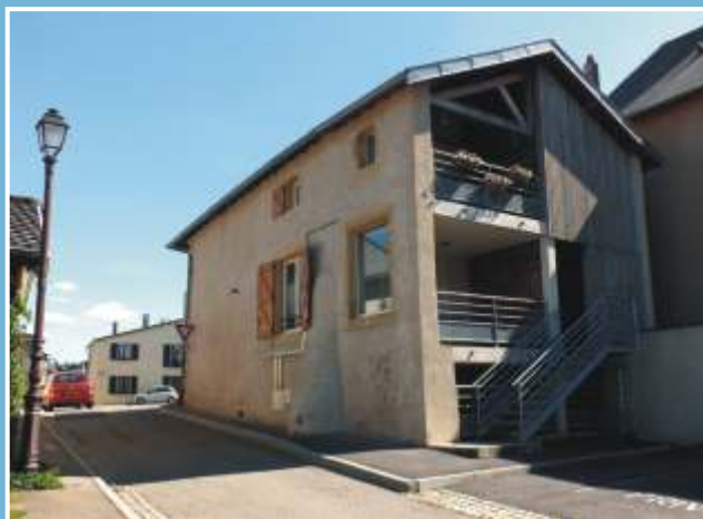
Logement rue des Pêcheurs
