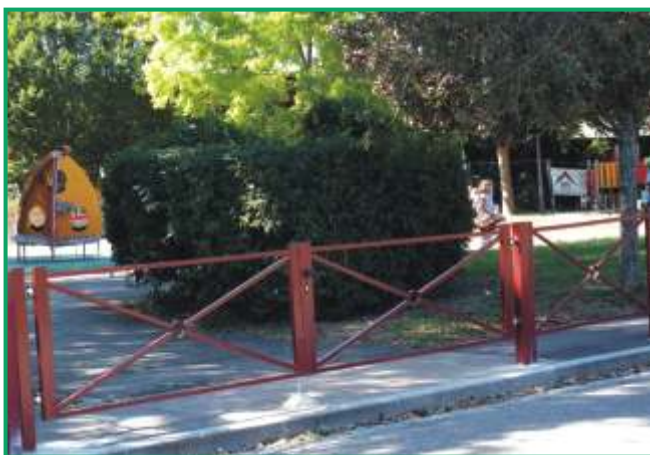
Installation d'un portail clôturant l'accès à l'aire de jeux devant le groupe scolaire. Les enfants ne pourront plus aller directement sur la route.
