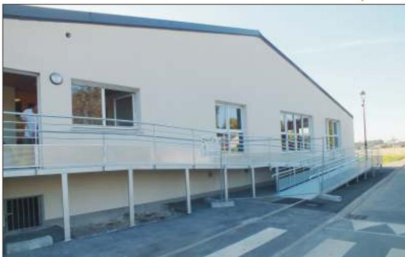
Etat d'avancement des travaux dans le cadre du réaménagement du périscolaire et de la mise aux normes : l'ancien ascenseur a été supprimé et est remplacé par une rampe d'accès métallique.
