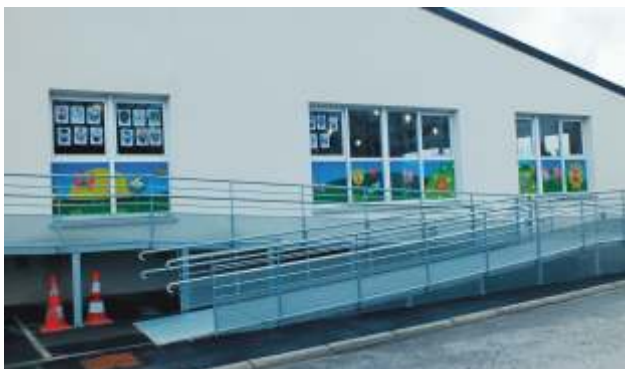
Préservation de l'intimité du périscolaire, par des films occultants ludiques apposés sur les vitres.
