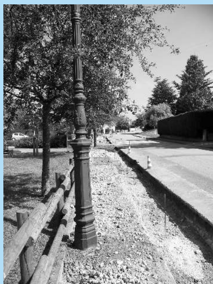
Travaux rue de Bussière et rue de Metz
