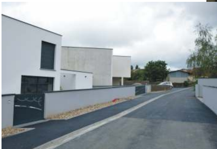
Rue des Mirabelliers : drainage et finitions
